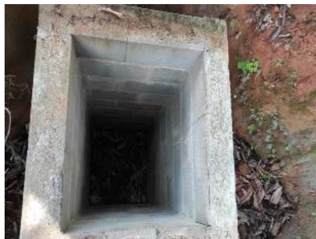
Foto 10 – Cx para registro de descarga (Interno)
