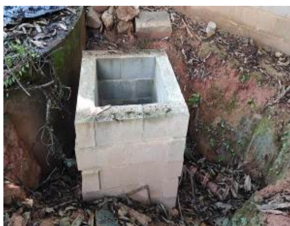
Foto 09 – Cx para registro de descarga
