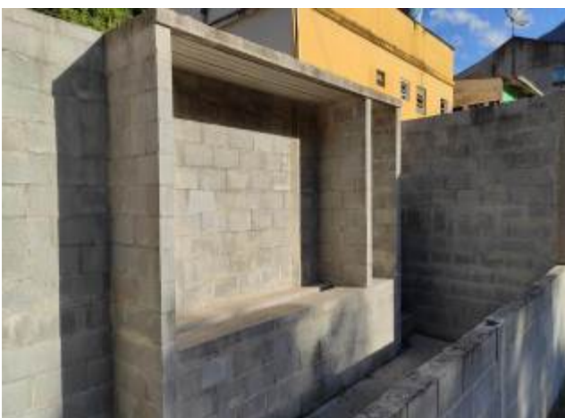
Foto 05 – Abrigo dos Quadros de comando
