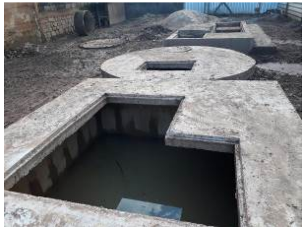
Foto 04 – Barrilete/Poço de sucção/caixa de areia
