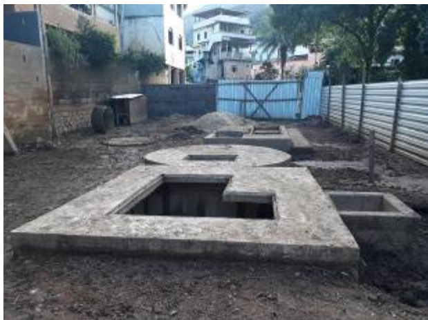
Foto 03 – Barrilete/Poço de sucção/caixa de areia
